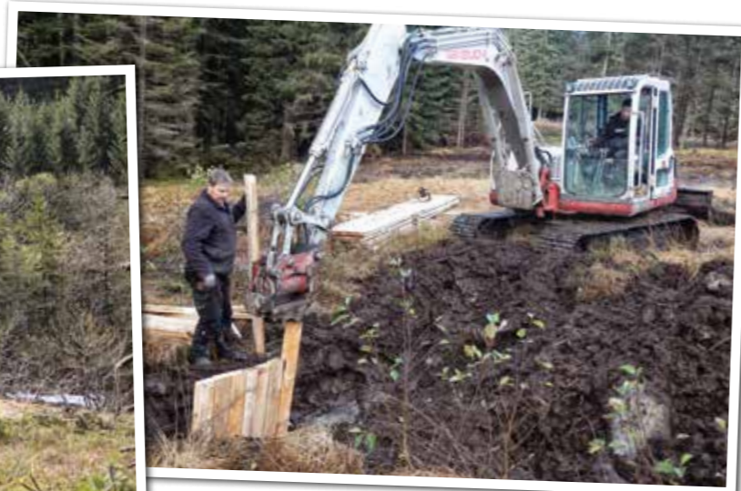
Einbau der Spundwände im Götzner Moos
