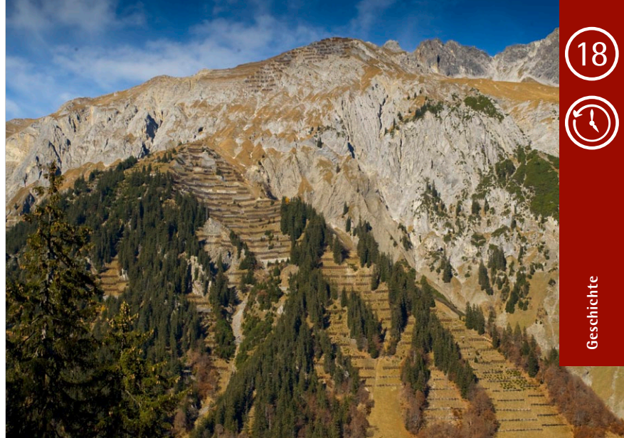
Abb. 60: Die Lawinenverbauung am „Blasegg“ oberhalb von Langen hat wahrlich Geschichte geschrieben. © Hanno Thurnher
