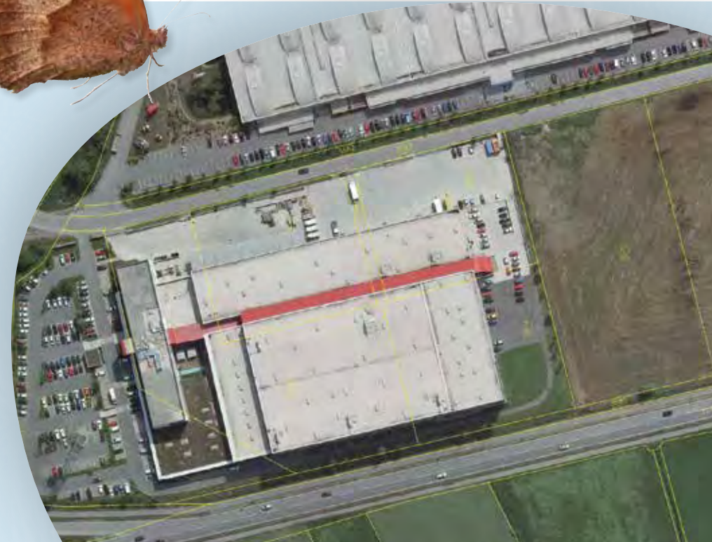
Luftbildaufnahme vor der Umgestaltung
